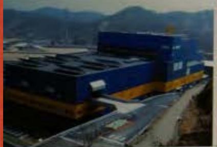
直島 中間処理施設
